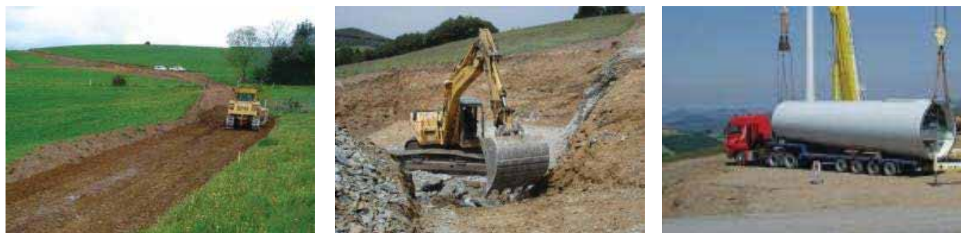
Photographie 148 : Illustration d'un chantier éolien
