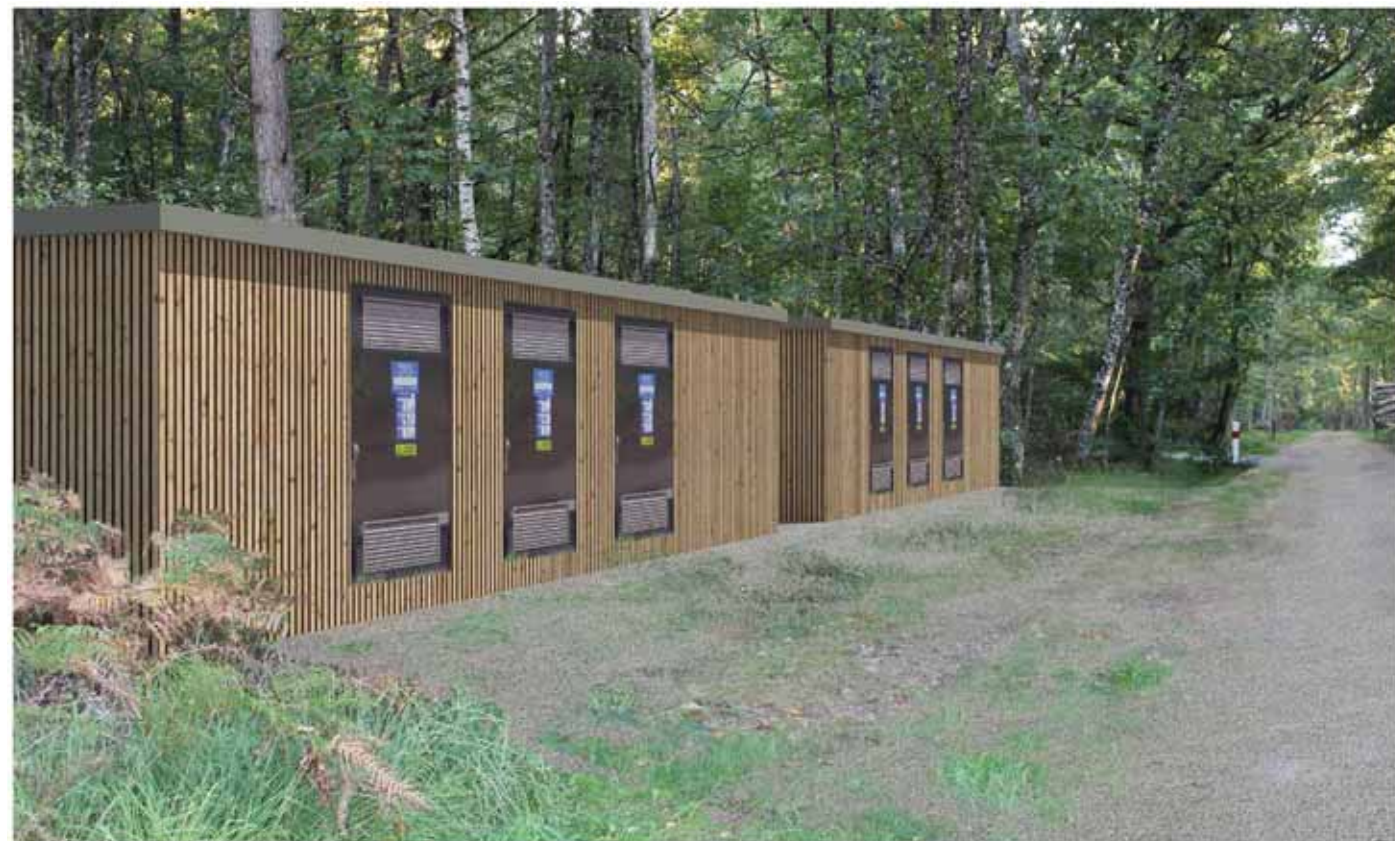
Photographie 183 : Simulation d'intégration des postes de livraison (réalisation : EDF EN)
